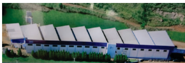
Estrutura fabril em 2014 - 3.293,70m 2
