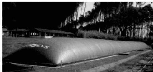
Figura 5 - Representação do biodigestor tipo Canadense.
