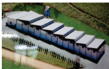
Estrutura fabril em 2010 - 2061,04m 2
