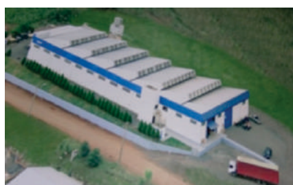
Estrutura fabril em 2011 - 2729,70m 2
