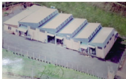
Estrutura fabril em 2004 - 1512,44m 2
