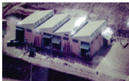
Estrutura fabril em 2002 - 800m 2
