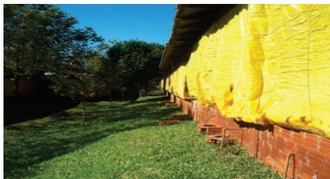
Figura 2: Tubulação coletora de dejetos
