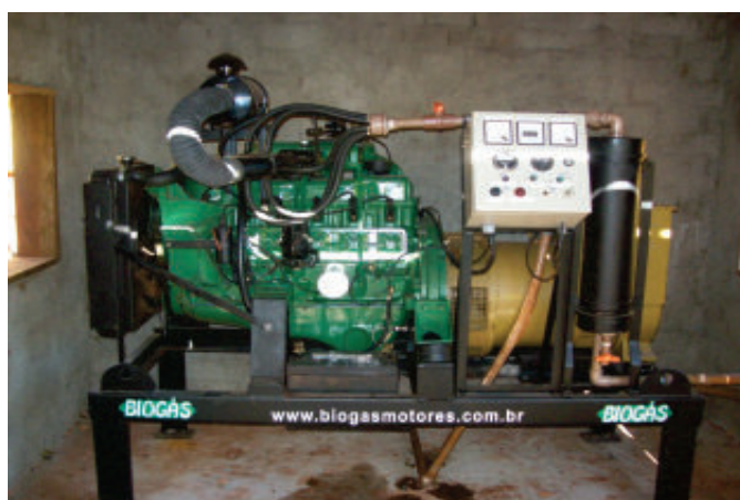
Figura 6: Conjunto motor-gerador
