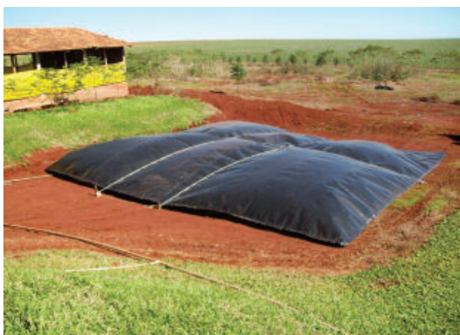
Figura 4: Balão de armazenamento
